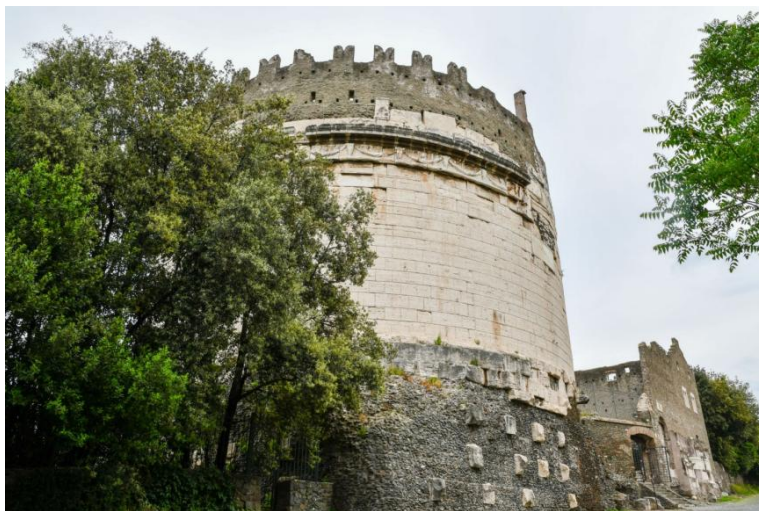
Fig. 1. Mausoleo di Cecilia Metella, 30-20 a.C., in opus caementicium e rivestimento in travertino ; la parte alta del tamburo è rivestita con un fregio in marmor pentelicum scolpito a rilievo con festoni vegetali e bucrani. È la rappresentazione del prestigio e del potere dell'aristocrazia romana. Reca ancora la scritta:
